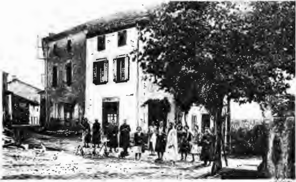
3. - St-REMY-de CHAGNAT (P.-de-D.). - Entrée de la Place de l'Ormeau
